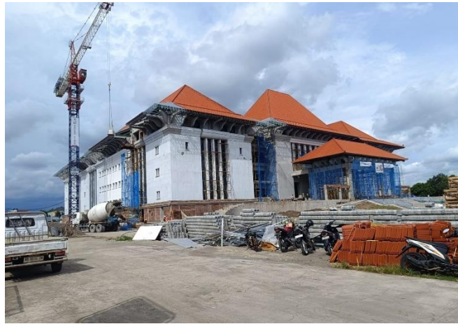
Gambar III. 3 Pembangunan Gedung DPRD DIY
